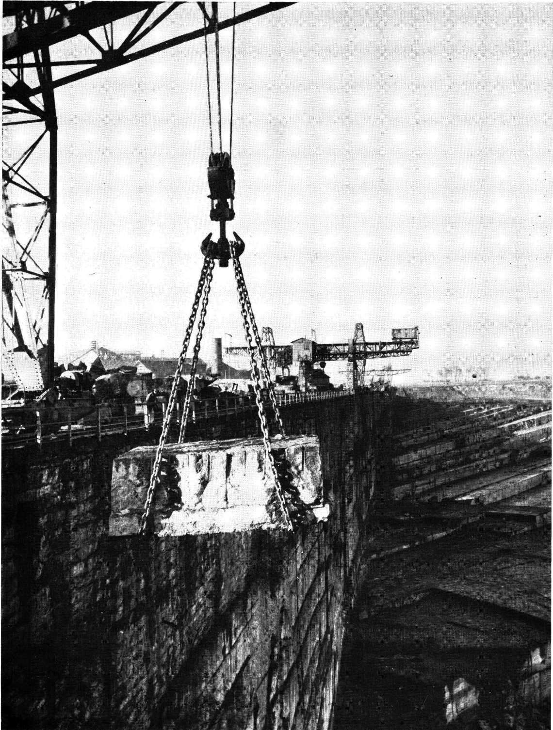
« Nouvelles Carrières du Hainaut » te Soignies. Regelmatige banken, zwak hellend. Zware heftoestellen op rollende bruggen.
